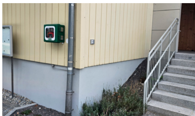
Standort des Defibrillators an der Nordseite der KiTa Wichtelburg
