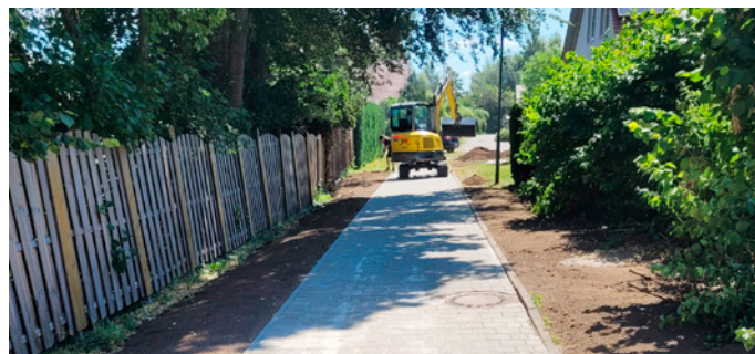
Sanierung Gehweg Am Brännle–Hauptstraße
